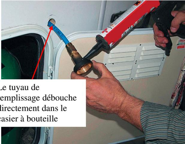
Le tuyau de remplissage débouche directement dans le casier à bouteille
